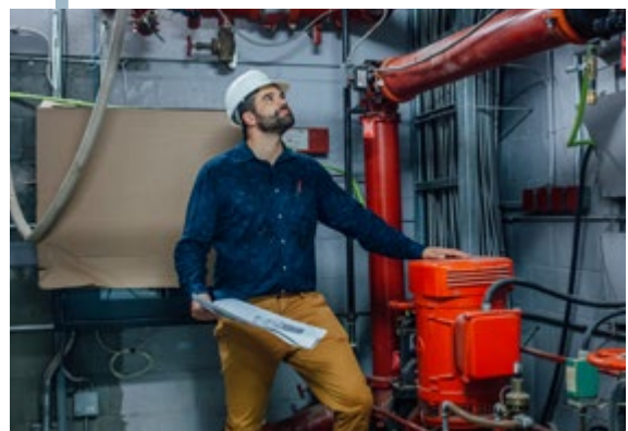
Début du programme RAM (Remplacement, amélioration et modernisation)
