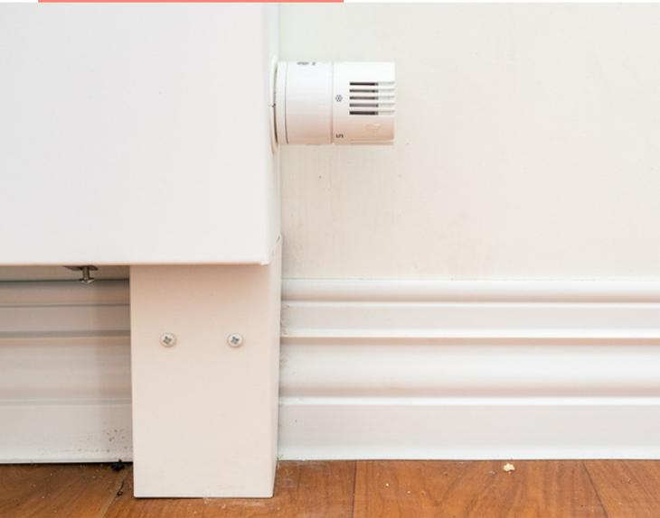
Dans le système de chauffage, l'introduction de l'air froid se fait par la partie basse du cabinet. L'air se réchauffe au contact d'un échangeur de chaleur, puis remonte et ressort par l'ouverture frontale sur le dessus du cabinet.
